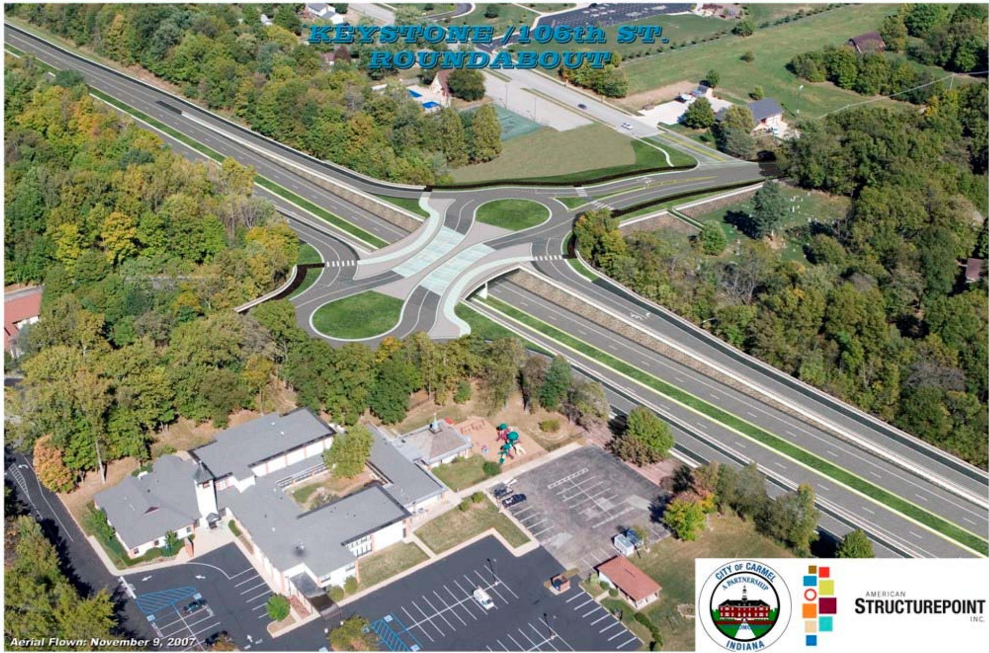
Dumbbell Interchange, Indiana, USA.
